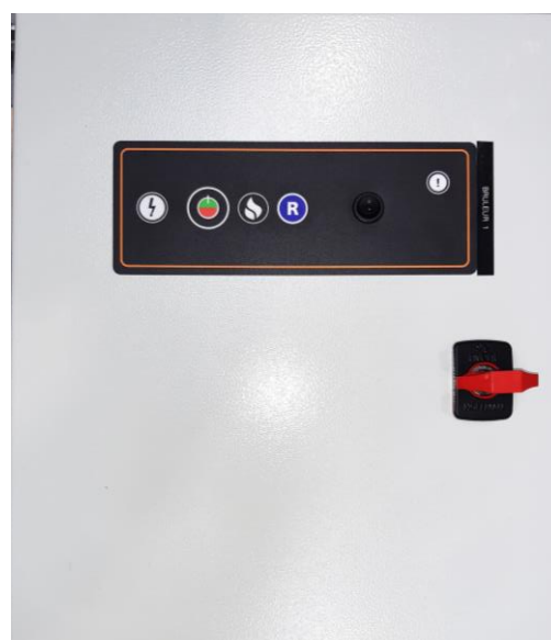
Système de commande de flamme pour fonctionnement à 1 ou 2 allures de chauffe,
